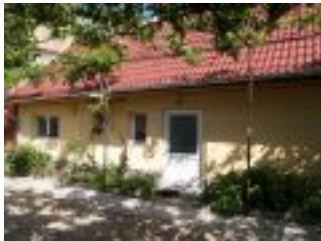
Außenansicht vom Ferienhaus Casa Romanita Haus 2
